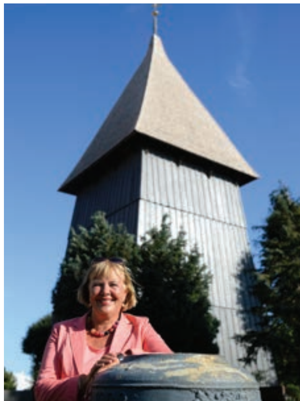
Sommer 2016: Der hölzerne Glockenturm der Petrikerche in Landkirchen nach der Renovierung (Foto: studio kohlmeier berlin)
