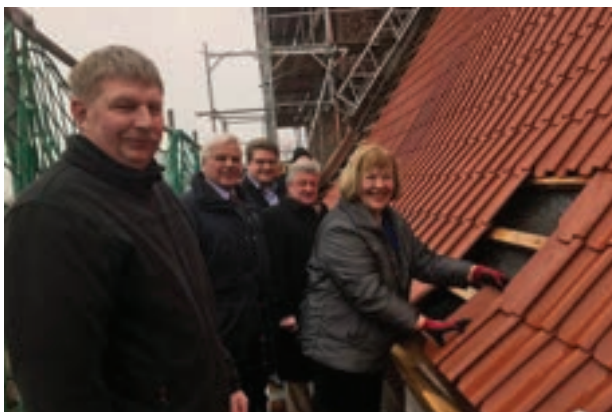
03.04.2018: Einsetzen der letzten Dachpfannen auf dem Dach der St. Jürgen-Kirche in Grube
